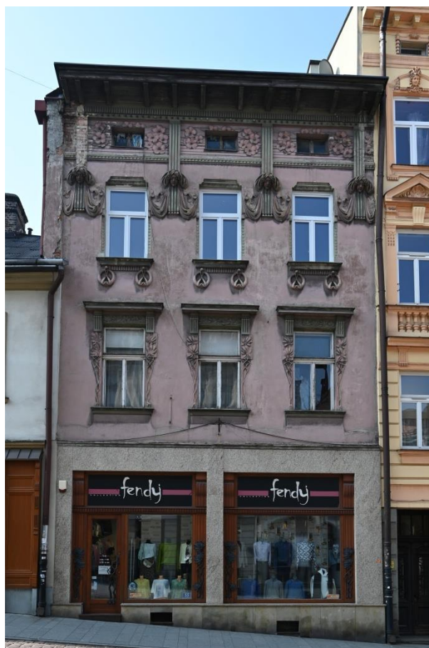
Il. 49. Cieszyn, ul. Głęboka, kamienica pod nr 55, fot. Michał Horbowicz, marzec 2025
