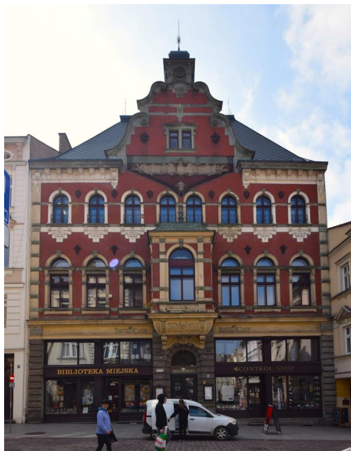
Il. 44. Cieszyn, ul. Głęboka, kamienica pod nr 15, fot. Michał Horbowicz, marzec 2025
