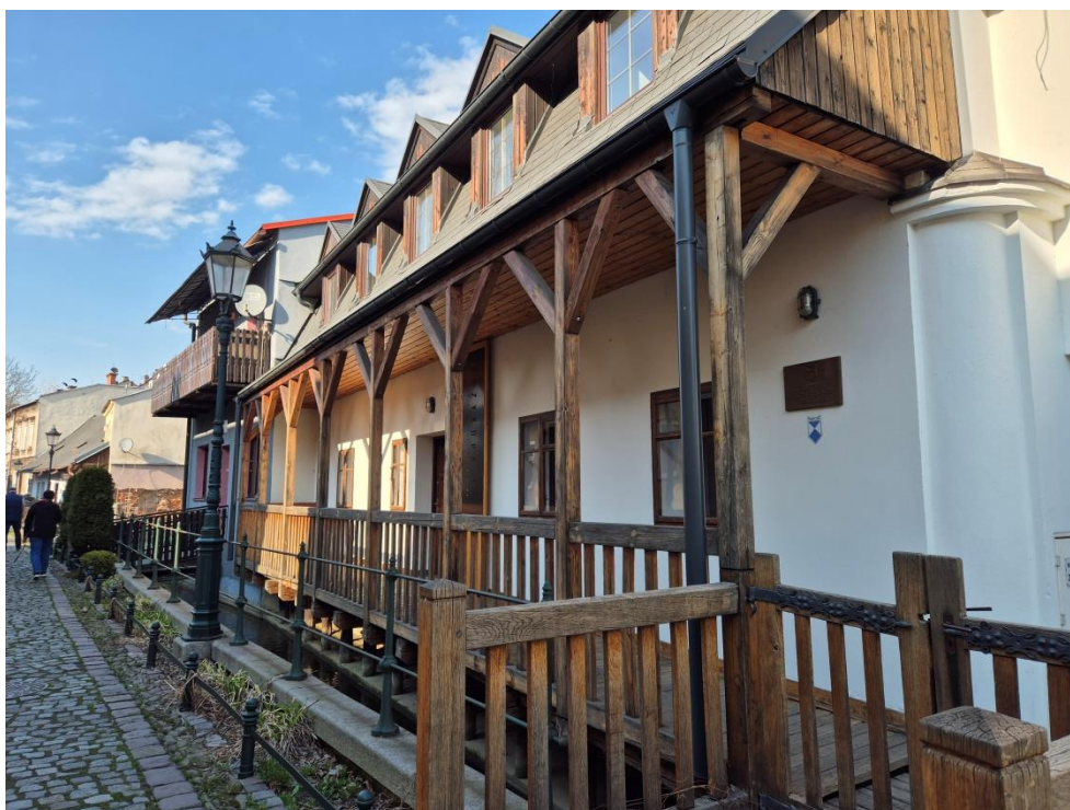
Il. 43. Cieszyn, ul. Przykopa, budynek pod nr 25, fot. Martyna Grabowska, marzec 2025
