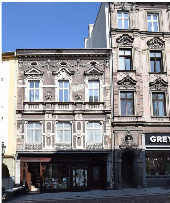
Il. 46. Cieszyn, ul. Głęboka, kamienice pod nr 28 oraz 26 (fragment), fot. Michał Horbowicz, marzec 2025
