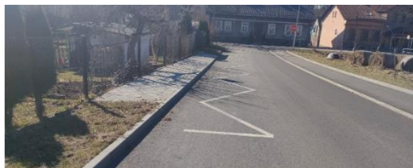
Wykonanie przystanku dla autobusów ul. Mickiewicza
