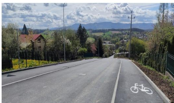
Przebudowa drogi gminnej nr 390072 S – ul. Mickiewicza w Cieszynie na odcinku od Al. Łyska do budynku mieszkalnego Mickiewicza 8
