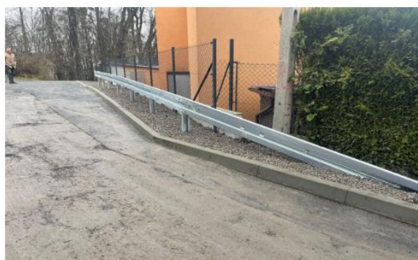
Przebudowa muru oporowego wzdłuż granicy nieruchomości przy ul. Górnej 36
