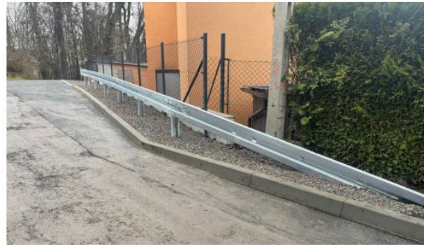
Przebudowa muru oporowego wzdłuż granicy nieruchomości przy ul. Górnej 36
