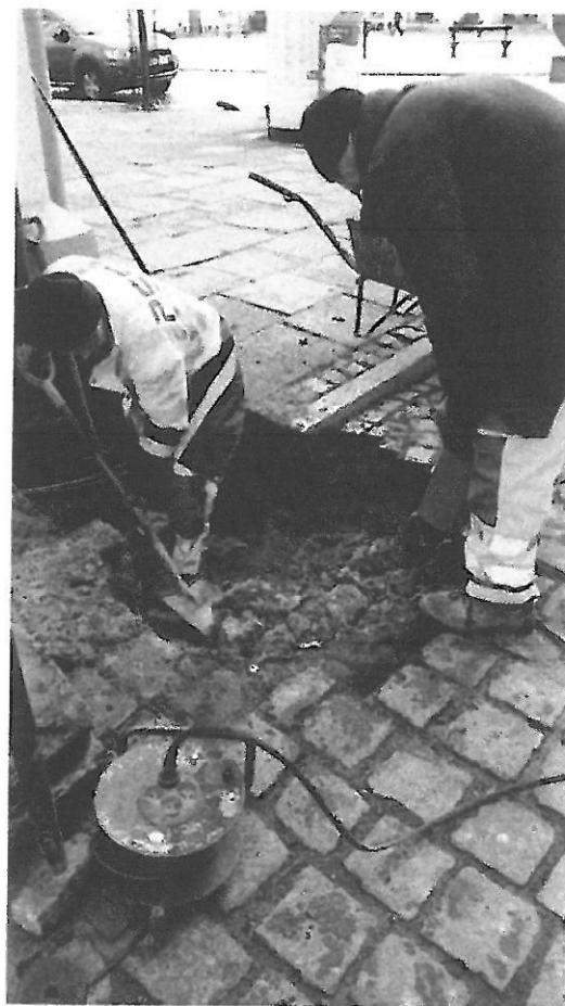
Rys. 16. Rozbijanie betonowej podbudowy młotem pneumatycznym przy budynku – foto właściciela
