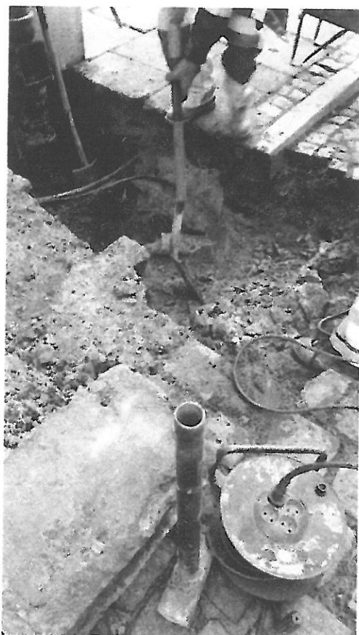
Rys. 16. Rozbijanie betonowej podbudowy młotem pneumatycznym przy budynku – foto właściciela
