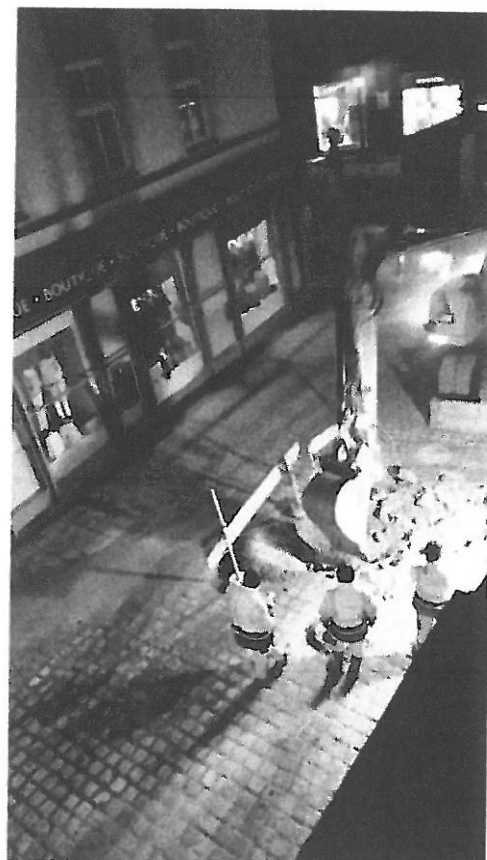
Rys. 18. Koparki pracujące przy budynku; rozbiórka kostki łyżką koparki; foto właściciela
