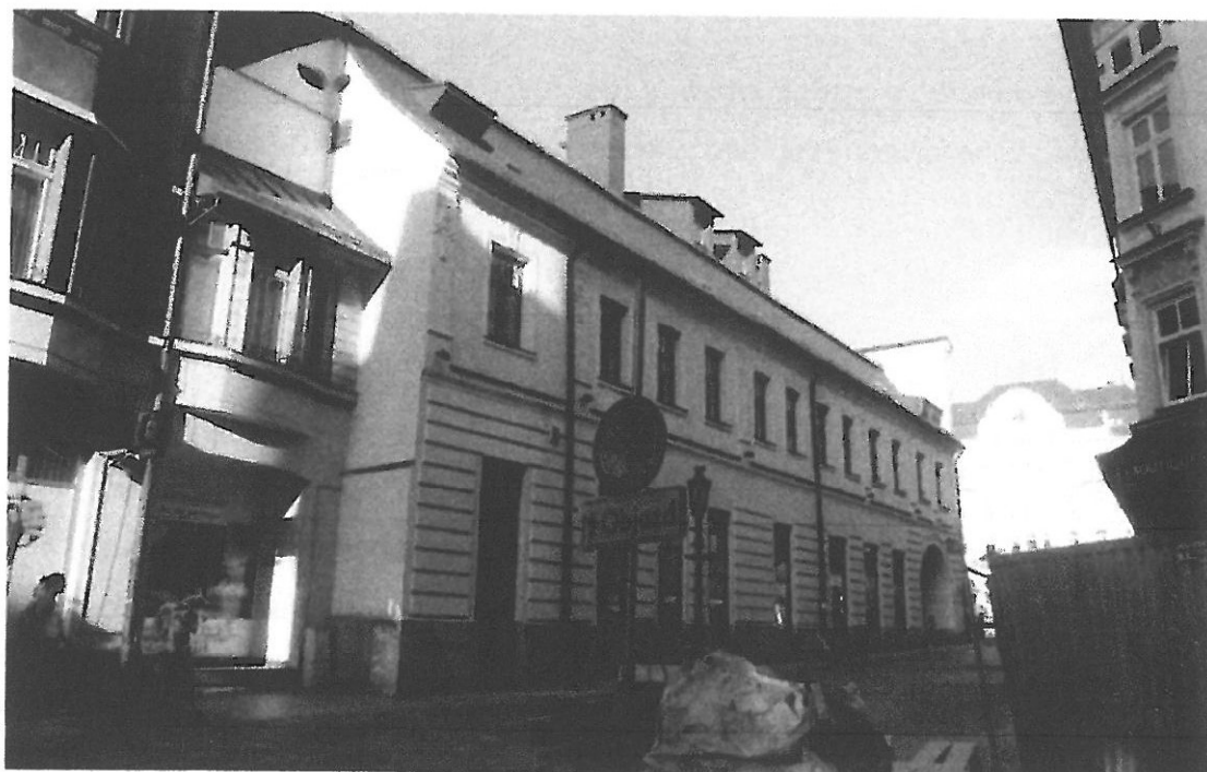
Rys. 2. Widok budynku od ul. Głębokiej; elewacja południowa
