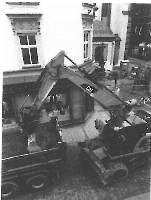
Rys. 18. Koparki pracujące przy budynku; rozbiórka kostki łyżką koparki; foto właściciela
