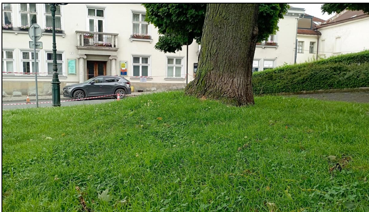
Gledziczja trójcierniowa, Pl. Teatralny – wybrzuszenie gruntu u podstawy pnia, widok od strony południowej (stan na dzień 27 czerwca 2024 r.).
